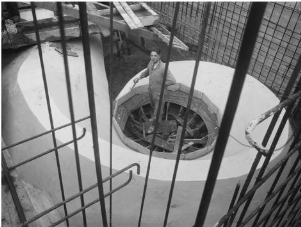
Betonnen slak constructie 1932 gemaal Gewende. Foto: the Memory / Stork foto collectie.
