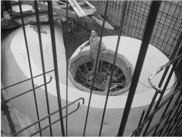
ตัวเลื้อเครื่องสูบน้ำที่ทำจากคอนกรีต (Concrete Volute) สร้างในปี ค.ศ. 1932 สถานีสูบน้ำ Gewende ภาพ: The Memory / Stork photo collection
